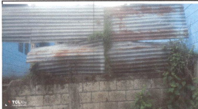
Foto 2: Muro perimetral del módulo 2
