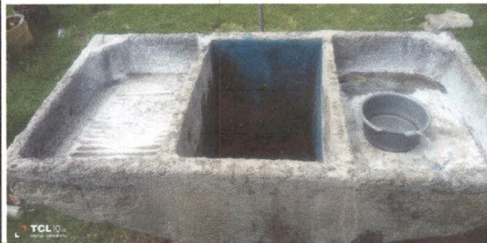
Foto 6: Cambio de pileta
