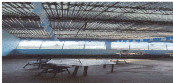
Foto 8: Interior del techo que se va cambiar Módulo 1
