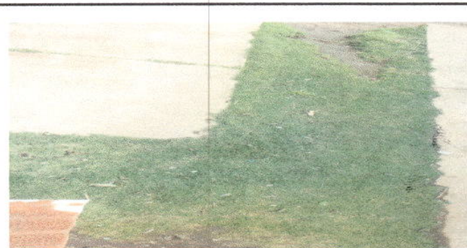
Foto 4: Reparación de piso de torta de cemento
